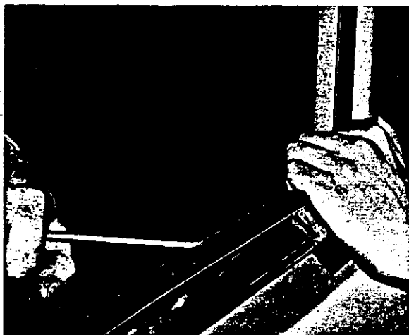
Abb. 48 Ausbau der Fensterleiste
