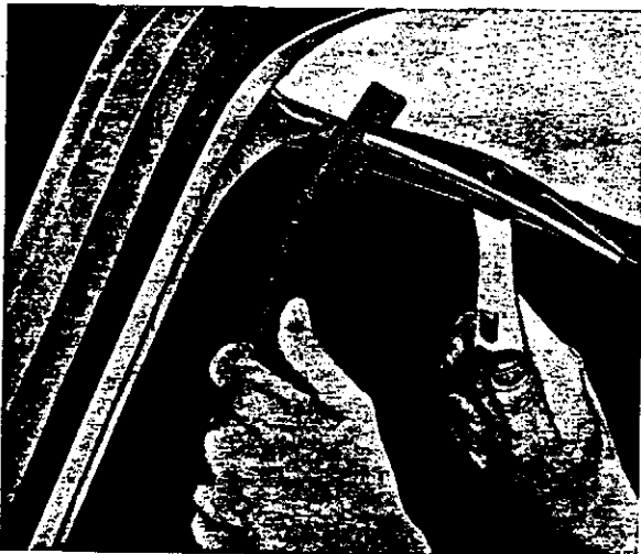
Abb. 45 Gezahnte Leiste wird angeschlagen
